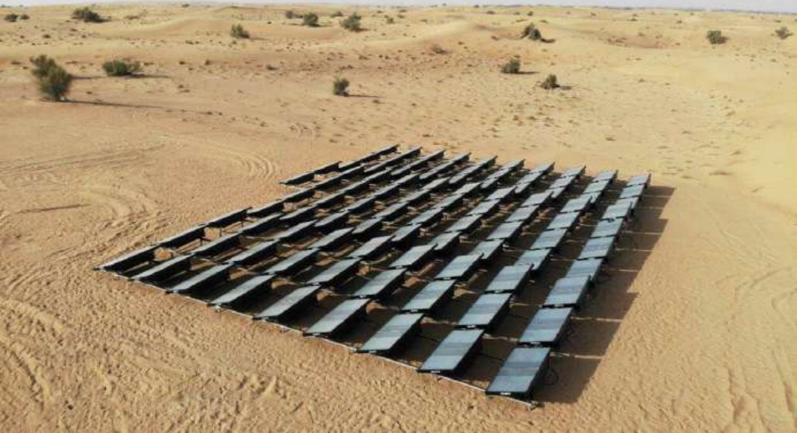
شکل ۱- مزرعه بزرگ هیدروپنل‌های SOURCE در بیابان امارات؛ نمونه‌ای از عملکرد فناوری تولید آب از هوا در اقلیم‌های فوق‌خشک (SOURCE Global, ۲۰۲۲)
